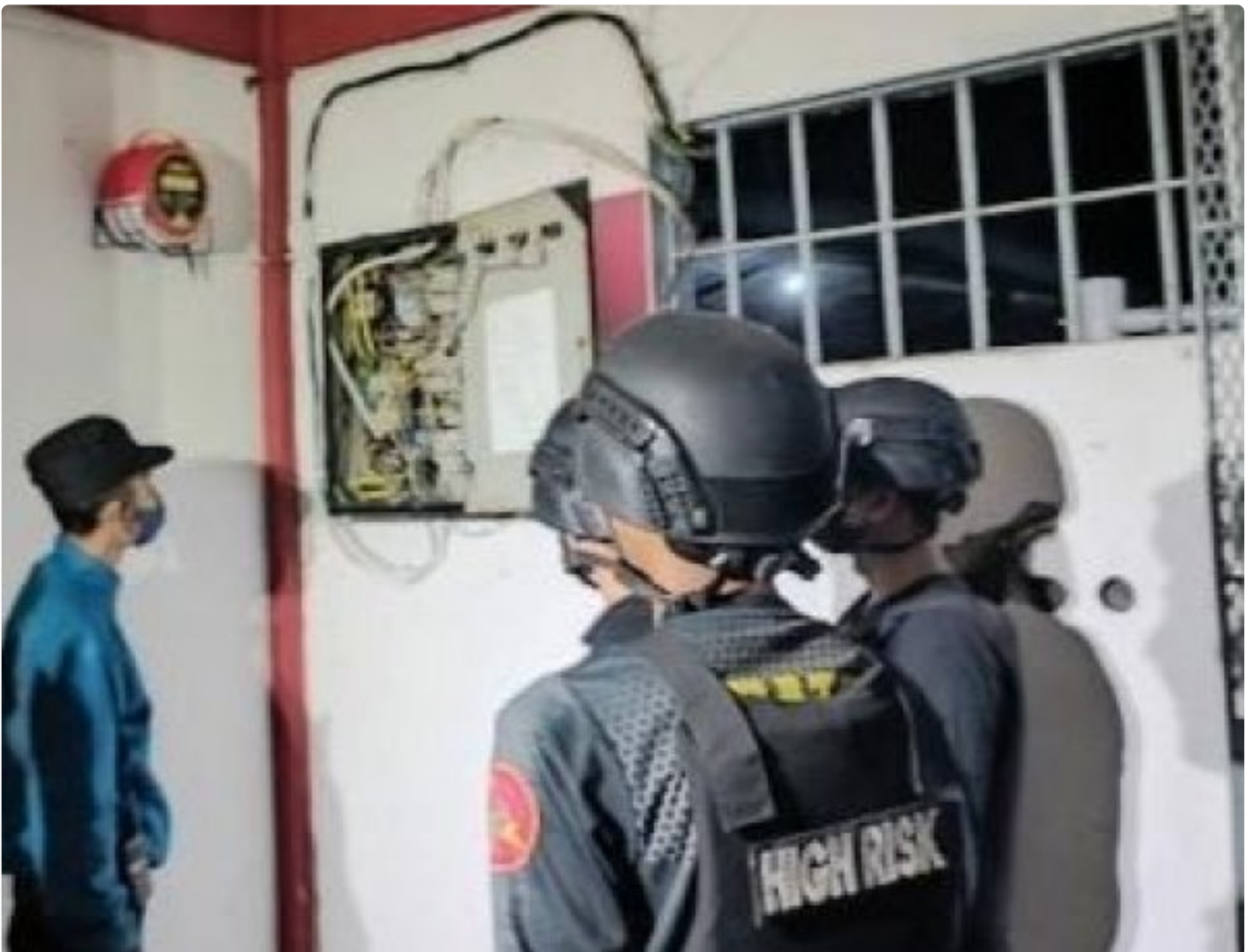
Maksimalkan Fungsi Apar Fire Block, Lapas Pasir Putih Pasang di Seluruh Ruangan Kantor dan Blok
